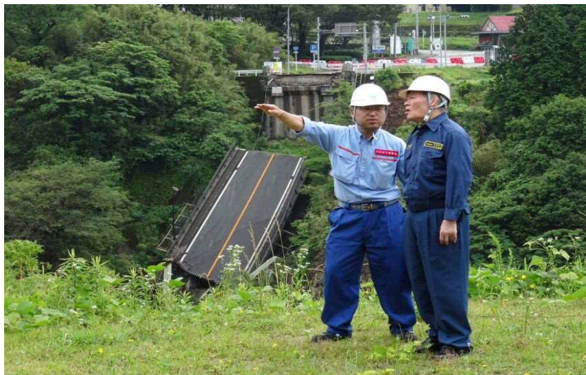
▲ 崩落した阿蘇大橋を視察
