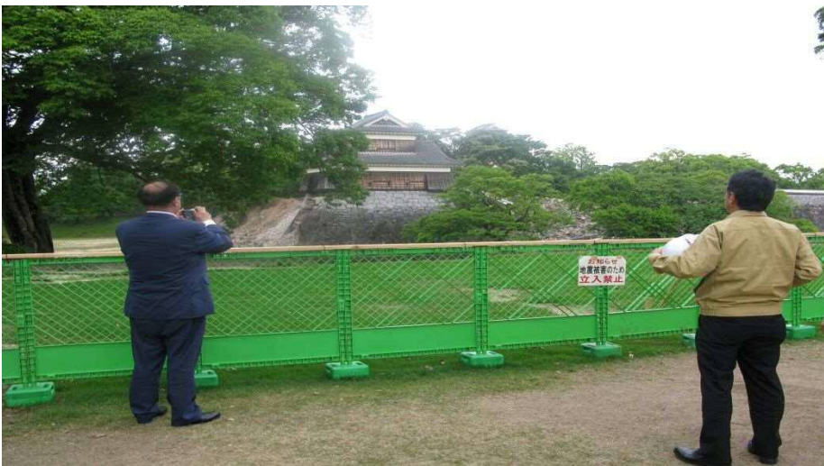
▲ 熊本城の被災状況を視察
