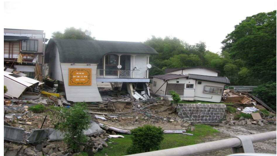
▲ 寺迫交差点付近の被災状況
