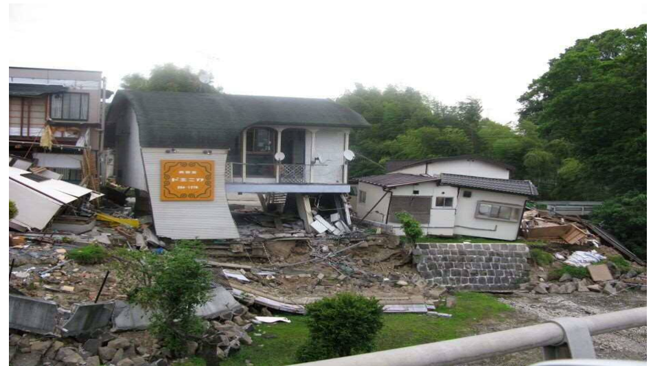
▲ 寺迫交差点付近の被災状況
