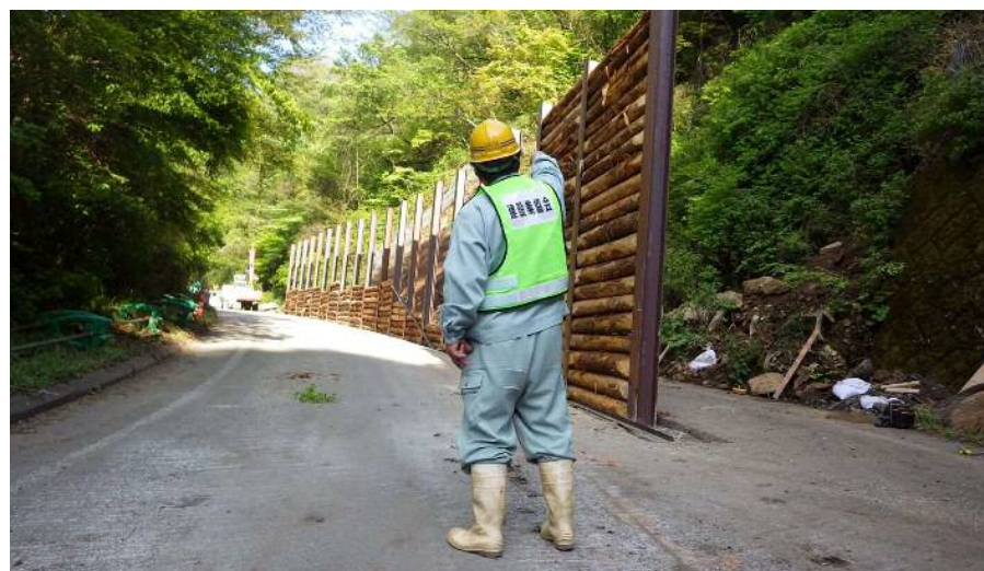
▲ 仮防護柵設置状況
