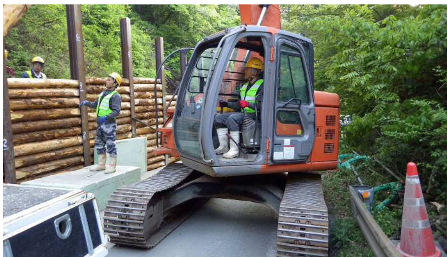
▲ 仮防護柵へ丸太設置②
