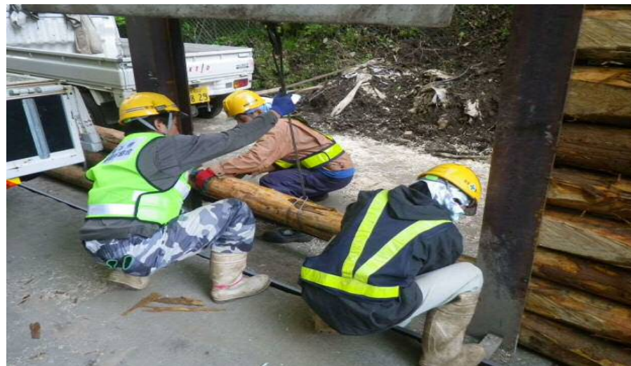
▲ 仮防護柵へ丸太設置①
