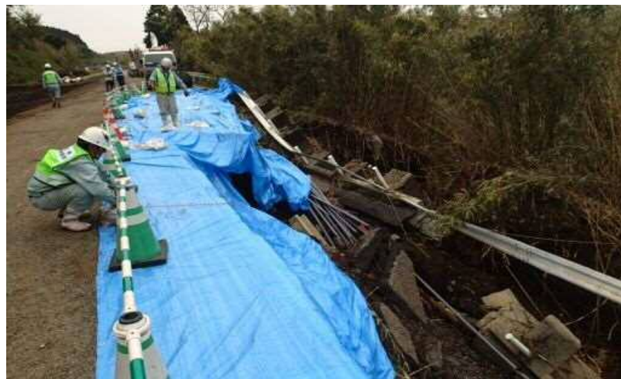
▲ ブルーシートによる養生
