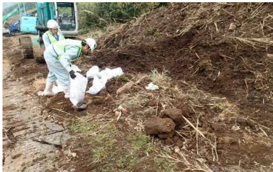
▲ 土のう作成・設置
