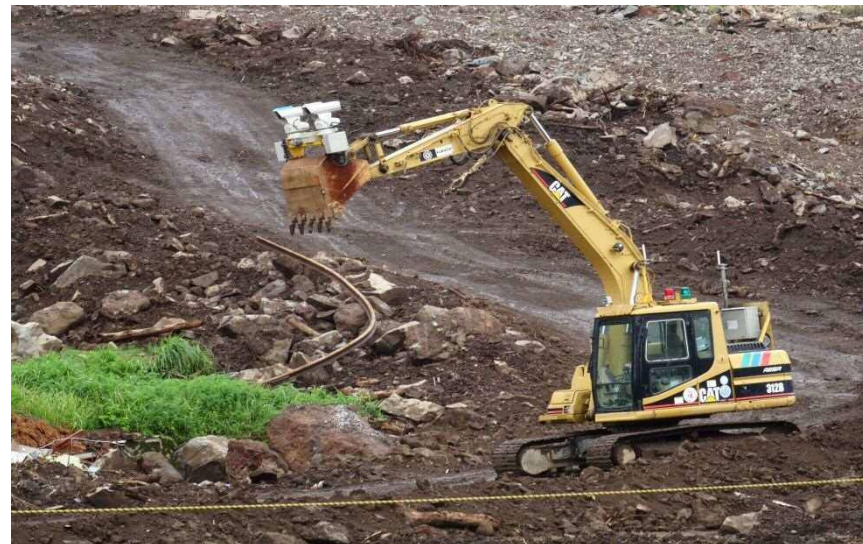
▲ 無人施工機で土砂撤去
