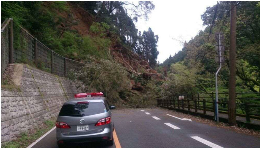
▲ 崩落時の状況
