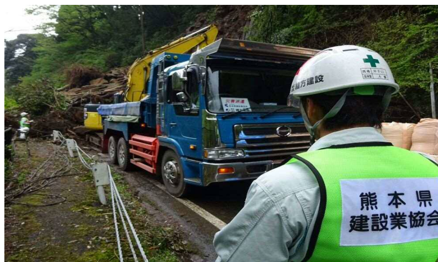
▲ 土砂、倒木の積込作業
