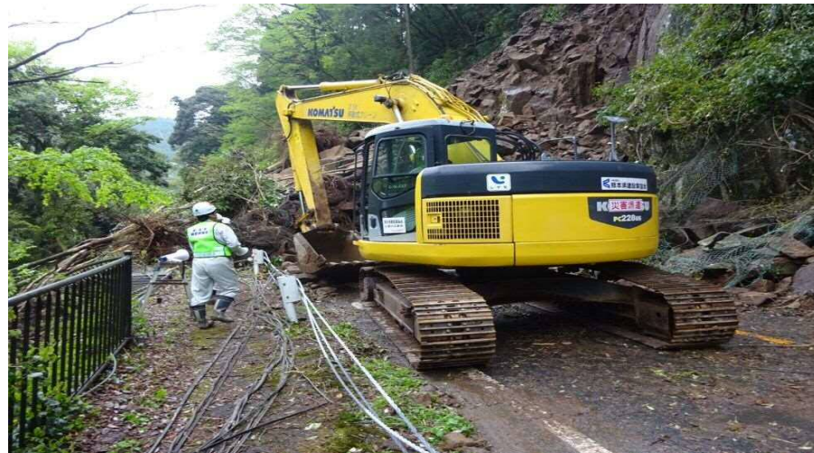
▲ 崩落土砂の撤去
